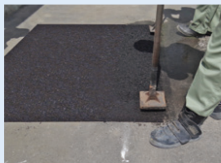
⑤スコップやタンバ、ビブロプレート等で十分に締め固めます。
