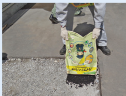
②ハイウェイパッチを必要量投入します。余盛りは3割程度です。
